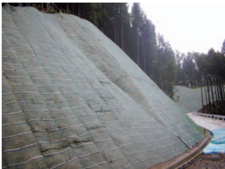
林道鷲沢2号線開設工事(山形県)
