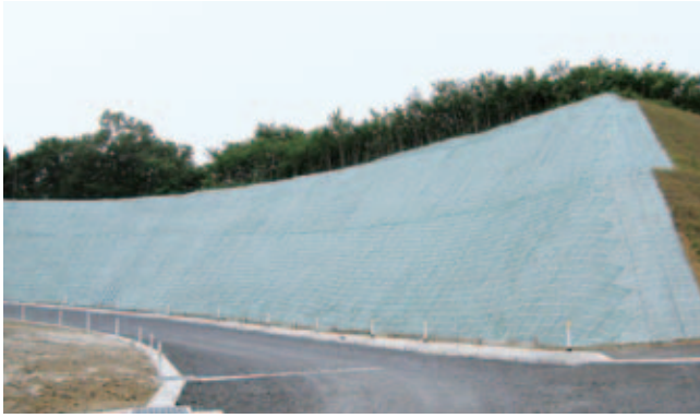
市道真滝中央線道路改良工事(岩手県)
