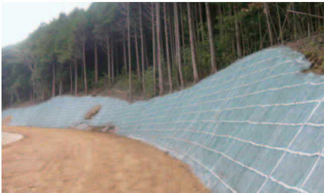
平戸中津良地区奥地森林保全緊急対策工事(1工区)(長崎県)
