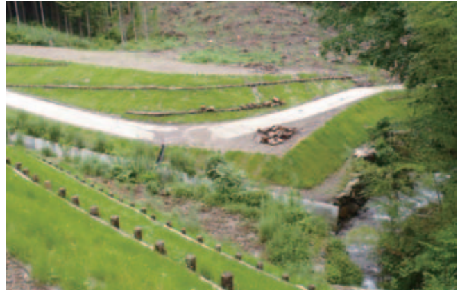
H21道交第2号曾家中西線3工区森林基幹道開設工事(大分県)
