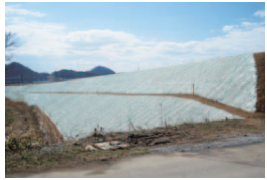
中野道路改良工事(青森県)
